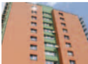
Karviná / bytový dům / Komplexní revitalizace
