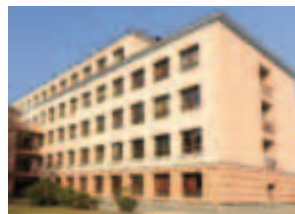
Olomouc / Univerzita Palackého Olomouc / Zateplení fasády a střechy
