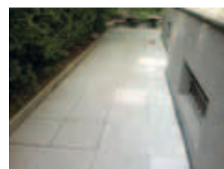
Úprava chodníku, zateplování soklu domu
