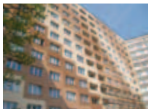
Ostrava / bytový dům / Komplexní revitalizace
