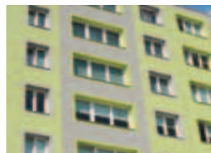
Ostrava / bytový dům / Komplexní revitalizace
