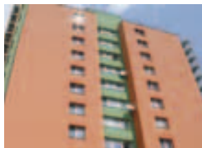
Karviná / bytový dům / Komplexní revitalizace
