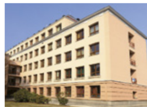
Olomouc / Univerzita Palackého Olomouc / Zateplení fasády a střech
