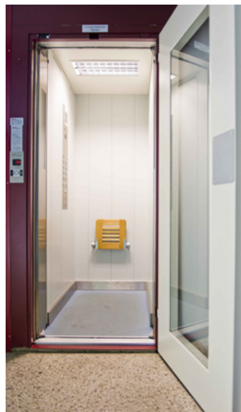
Modernizace výtahu: MSV Liberec
