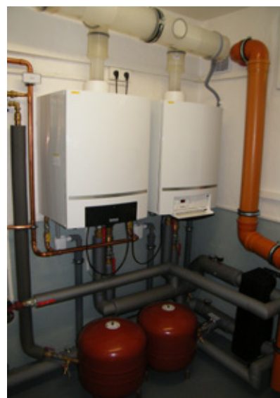
Obr. 3: Nástěnné kondenzační kotle Logamax plus GB162-45
