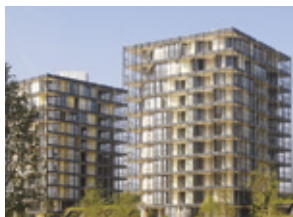
Central park Praha / anhydritové podlahy, Kompletní zateplení fasády
