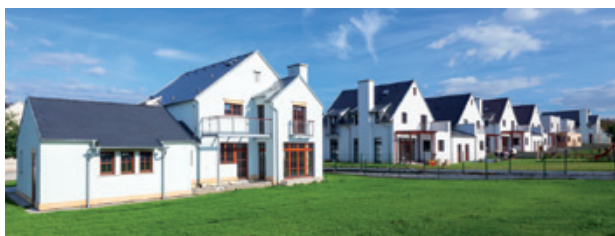
Praha-Benice / Obytný komplex / Kompletní dokončení domů z hrubé stavby
