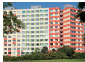
Praha / bytový dům / Kompletní zateplení fasády a střechy
