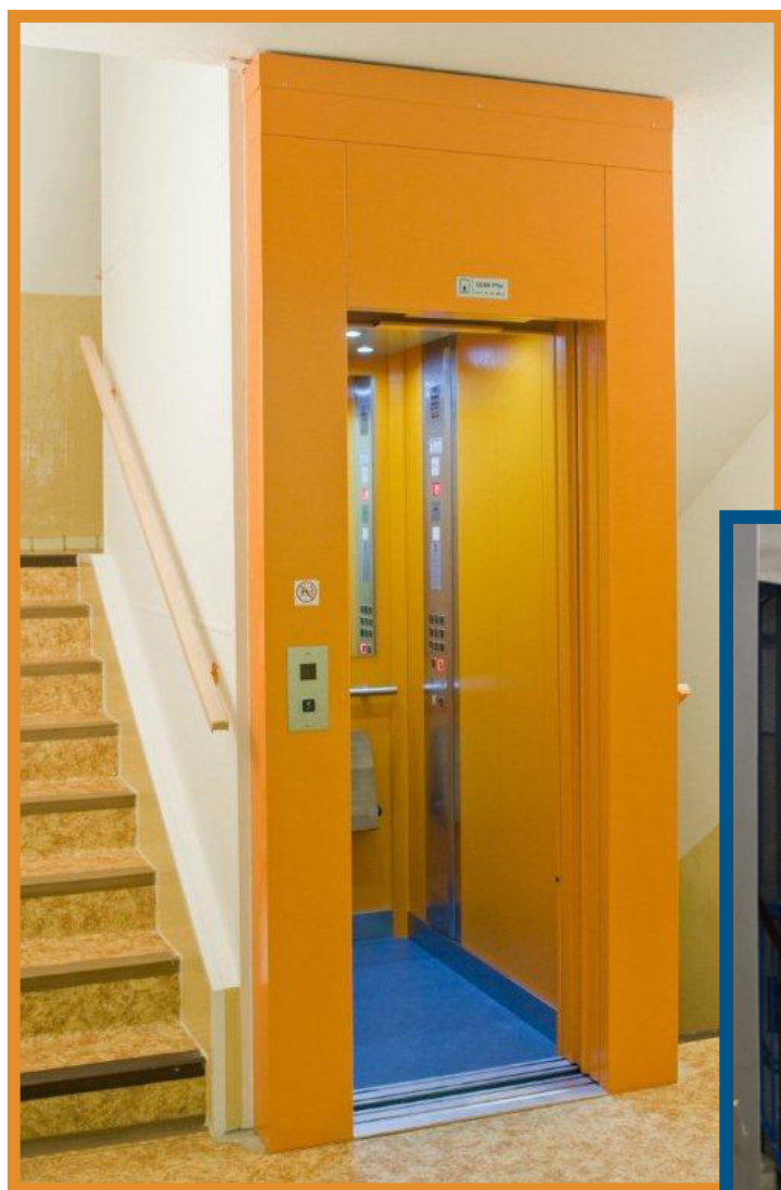
Výtah po rekonstrukci a před rekonstrukcí
