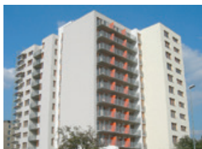
Praha / bytový dům Antal / Kompletní zateplení fasády
